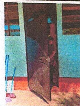
Foto 6: Finalización de puertas reparadas.
