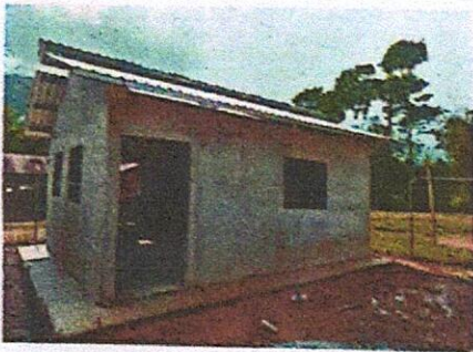
Foto 1: Se puede observar las paredes finalizadas, repelladas, cubierta de lámina, balcones y puerta.
